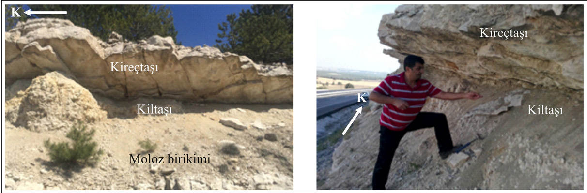
Şekil 2- Kil içeren kayaların dip oyulma süreçleri sonucu kaya düşmesi riskini taşıyan geniş süreksizlik aralığına sahip kalın kireçtaşı tabakaları (L7).
