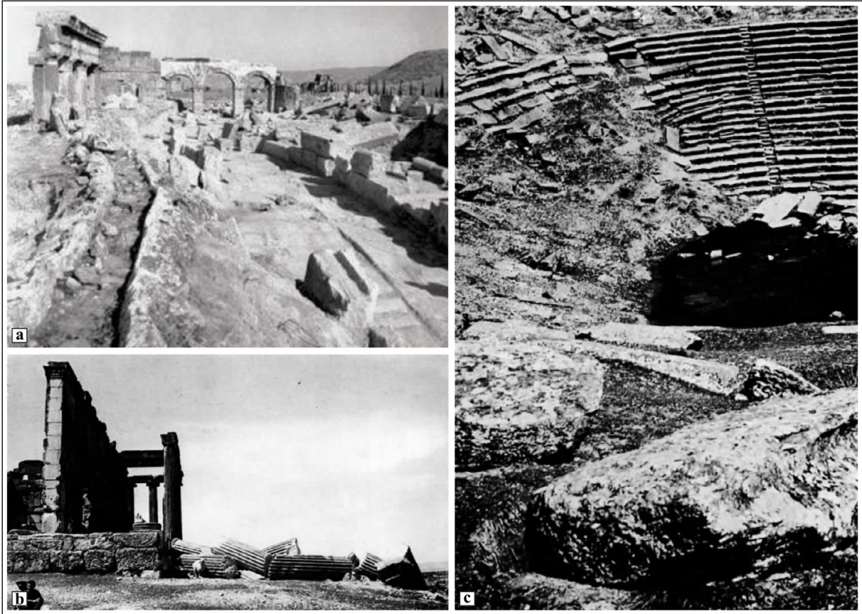
Şekil 6- a) D'Andria (2008)'de sunulmuş ve Hierapolis'teki 1963 kazılarında çekilmiş Frontino Kapısı'na uzanan Plateia'da (kent meydanı) 7. yy depreminde meydana gelmiş deformasyonları gösteren fotoğraf. Rudolf Naumann'ın Aizanoi antik kentinde 28 Mart 1970 Gediz Depremi sonrası oluşan hasarları belgelediği çalışmasındaki bazı fotoğraflar; b) Zeus Tapınağı sütunlarındaki sistematik sıralı devrilmeler, c) Tiyatro caveasındaki deformasyonlar ve yere gömülü olan büyük mermer bloklardaki yanıl yer değiştirmeler.
